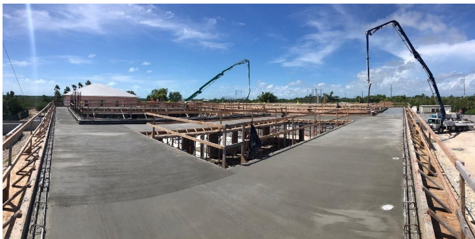
Roof slab pour
